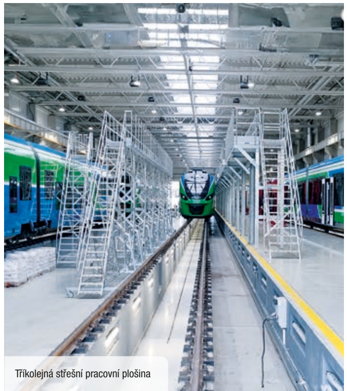
Pochozí podlaha s ochranou proti nárazu a sklopným zábradlím
